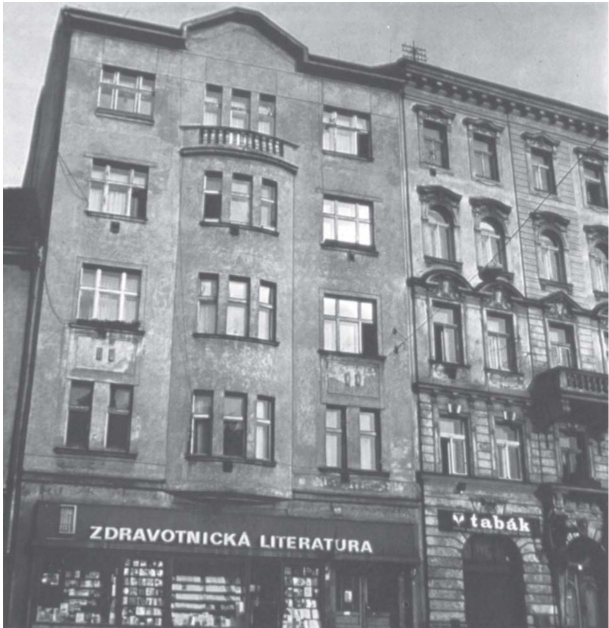
Vedere actuală a casei în care au locuit Șerban și Mihai Eminescu la Praga, pe strada Lipova (Teiului), nr. 471.
